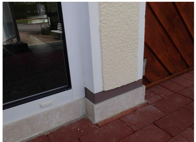
Und wem die jetzt angeschrägte Bordsteinkante ins Auge gefallen ist, das ist nicht etwa ein Schaden, sondern dient Rollstuhlfahrern zur Erleichterung.
